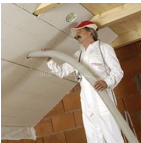
Slika 20. Ugradnja papira u konstrukciju (upuhivanje)
