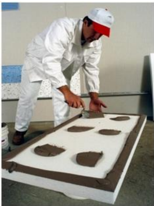
Slika 7. Nanošenje ljepila na stiropor ploču
