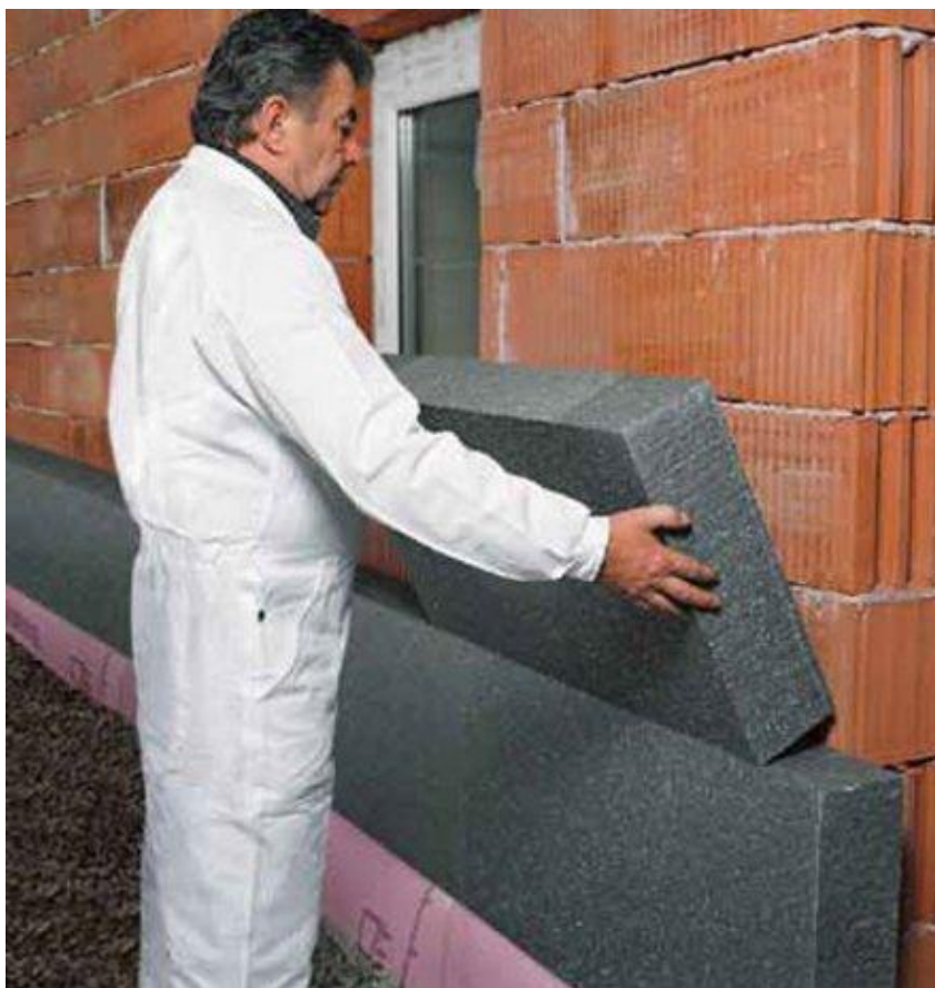
Slika 5. Ugradnja sivog stiropora
