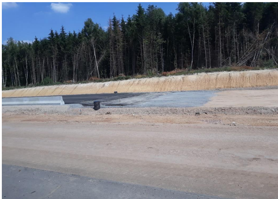
Slika 7 Završni sloj nasipa- posteljica- asfalt
