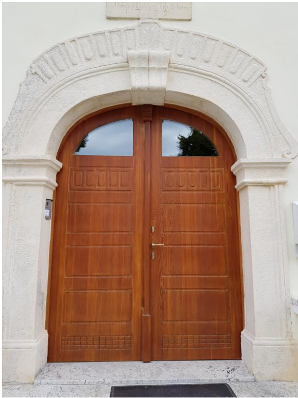
Slika 3.7.1. Restaurirani kameni okvir na glavnom ulazu u župni dvor
