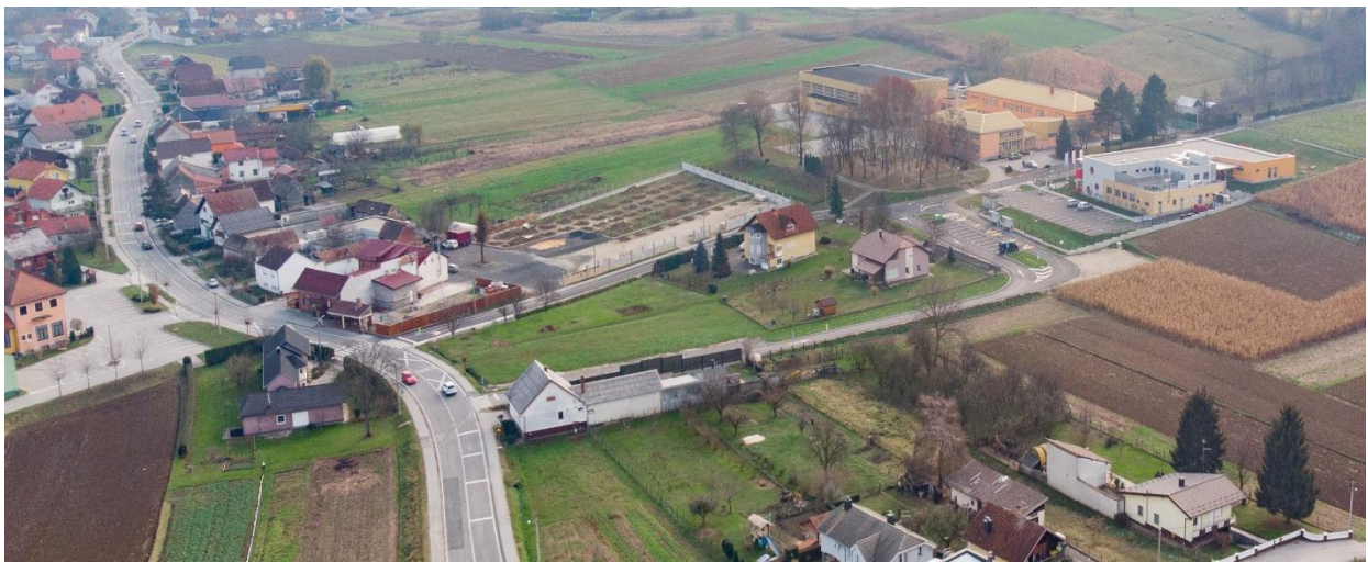
Slika 3.3. Panoramska fotografija sa prikazom Osnovne škole i Dječjeg vrtića u odnosu na Topličku ulicu
