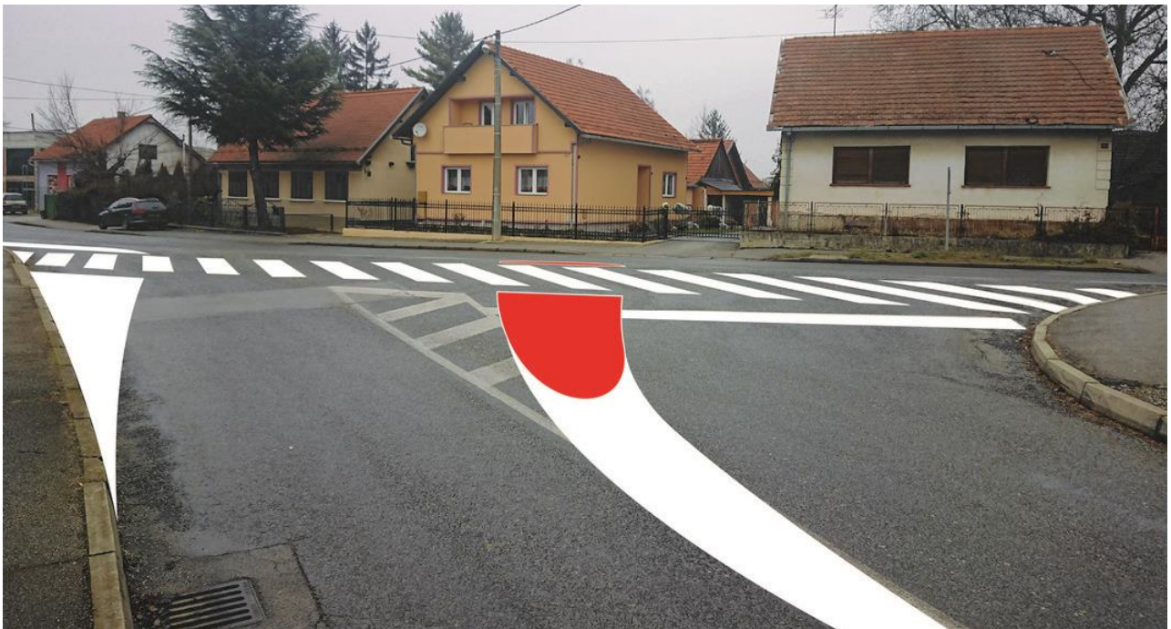
Slika 7.5. Obilježeni pješački prijelaz na križanju Topličke i Kneginjegradske ulice duljine 24 m, pogled iz smjera Topličke ulice, te Kneginjegradske ulice-prikaz predloženog zahvata Izvor: izrada autora
