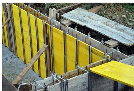
Slika 3.3. Primjer izvedbe AB zida
