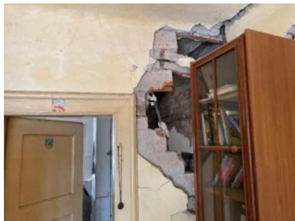
Slika 5.18. - Pregradni poprečni zid (istok-zapad)
