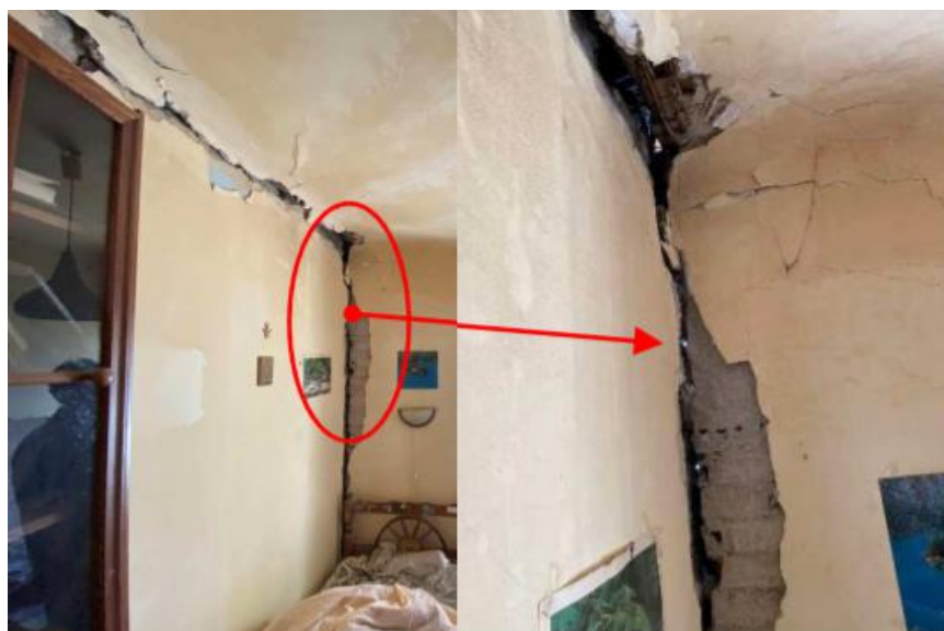
Slika 5.16. - Pogled na jugoistočni kut stana ali i cijele zgrade
