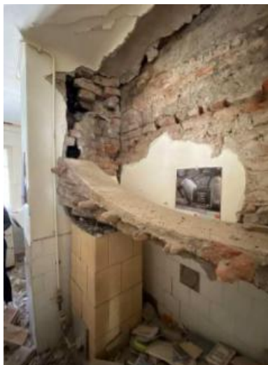
Slika 5.15. - Pogled uzduž krajnjeg istočnog nosivog zida
