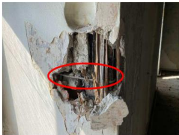
Slika 5.21. - Ručno izvedena oštećenja na zidu i podnoj konstrukciji
