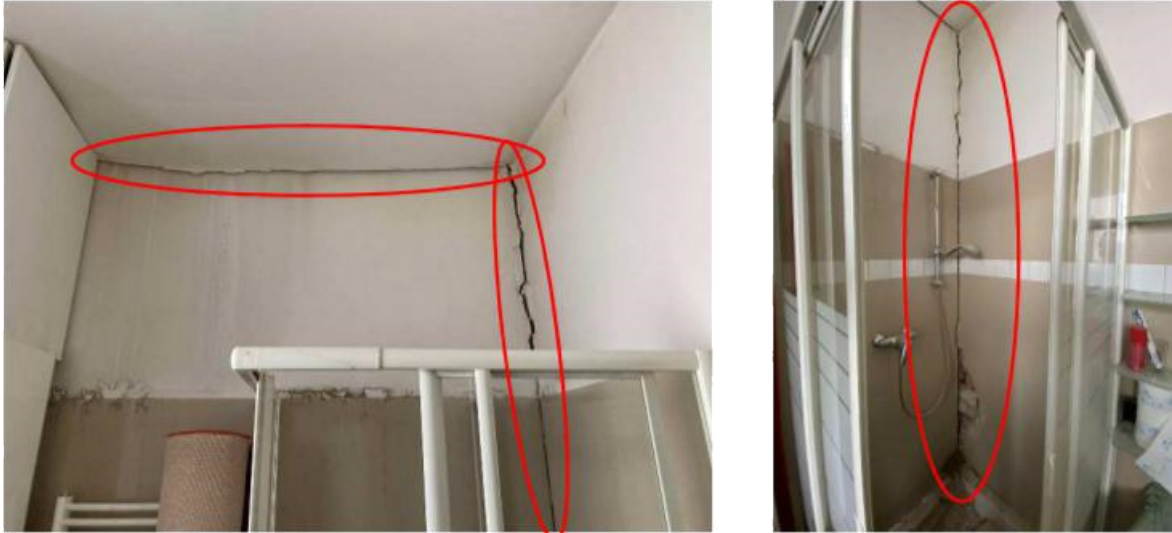
Slika 5.12. - Sanitarni prostori na krajnjem istočnom zidu stana i zgrade
