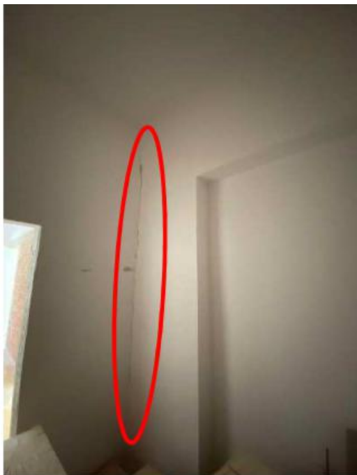
Slika 5.33. - Vertikalne pukotine zidnih gipskartonskih obloga
