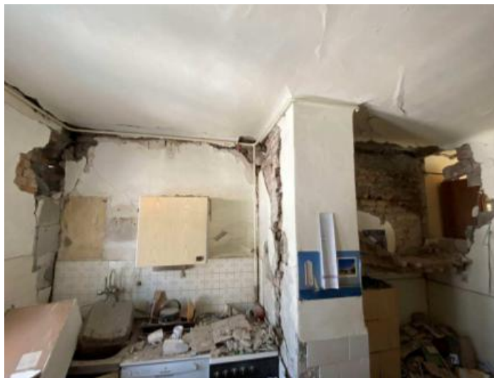
Slika 5.13. - Pogled na krajnji nosivi istočni zid zgrade
