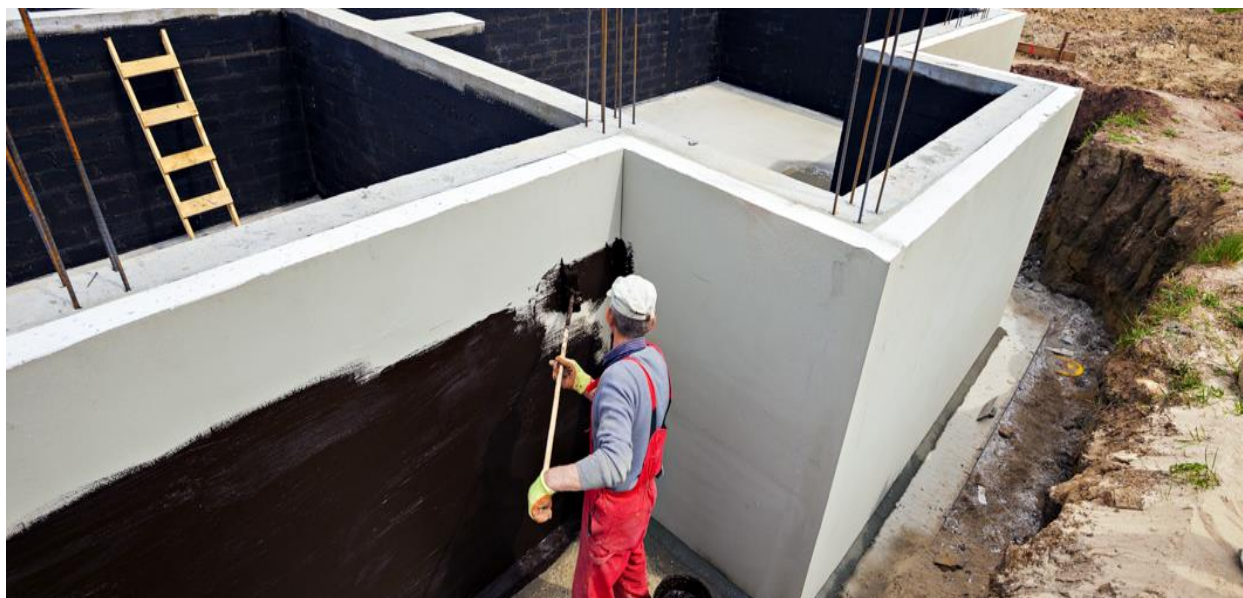
Slika 3.5 Zaštita konstrukcije objekta koja je djelomično podrumljena
