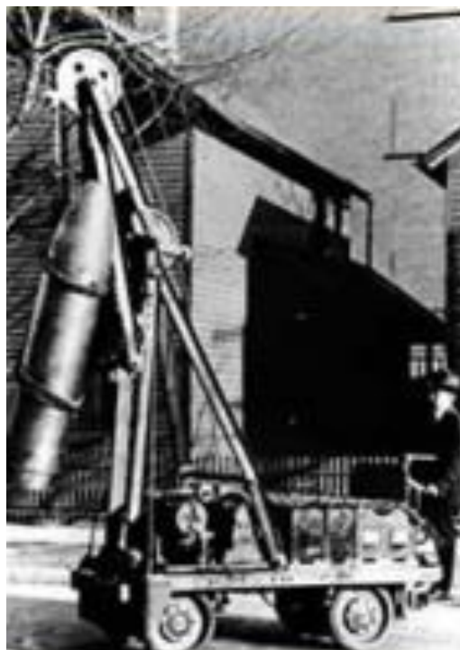
Slika 2.2: Prvi električni viličar [17]
