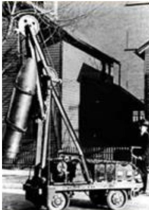
Slika 2.2: Prvi električni viličar [17]
