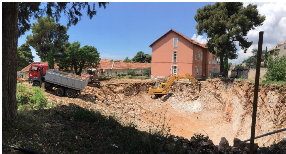
Slika 3.2 Iskop i odvoz materijala
