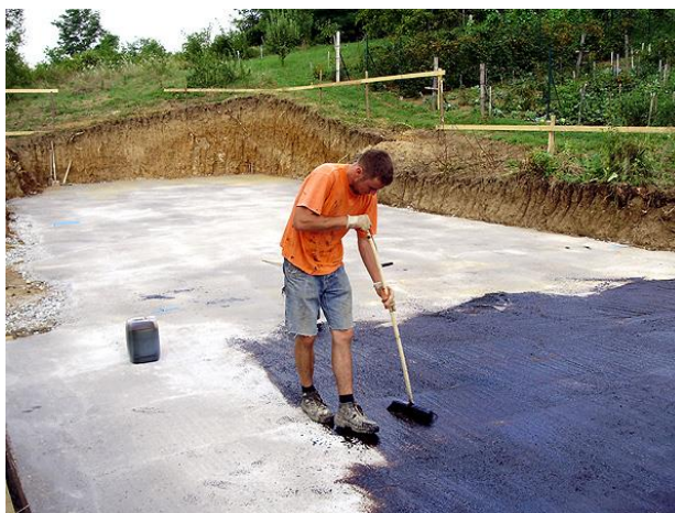
Slika 9.2.2. Nanošenje bitumenskog prednamaza
