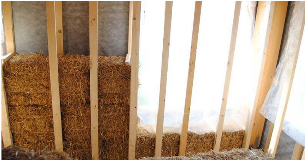
Slika 4.1.5. Ugradnja slame kao izolacijski materijal
