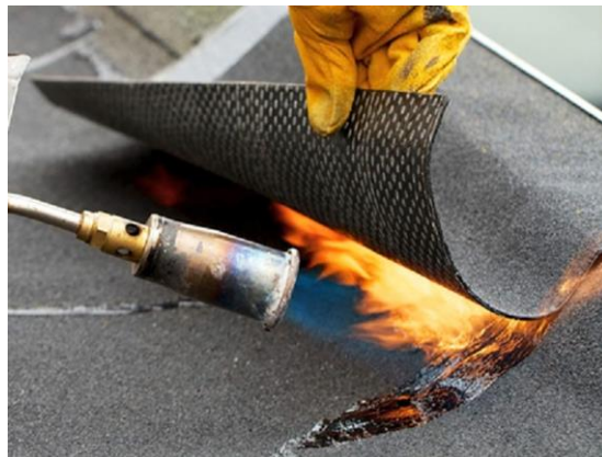
Slika 9.1.1. Varenje bitumenske trake
