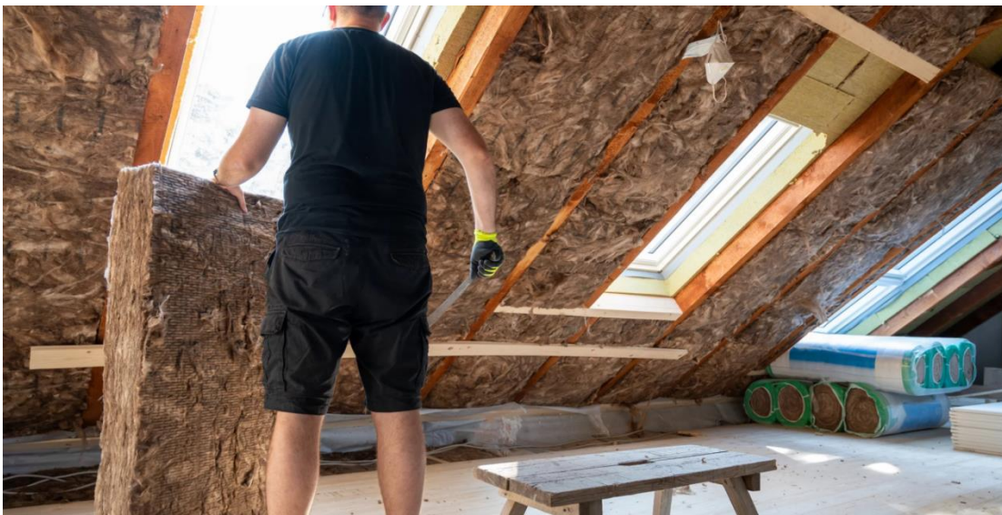
Slika 4.3.5. Izolacija potkrovlja staklenom mineralnom vunom
