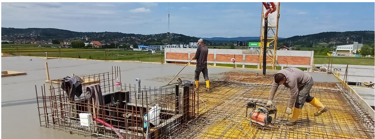
Slika 21. - Betoniranje stropne ploče u velikoplošnoj oplati
