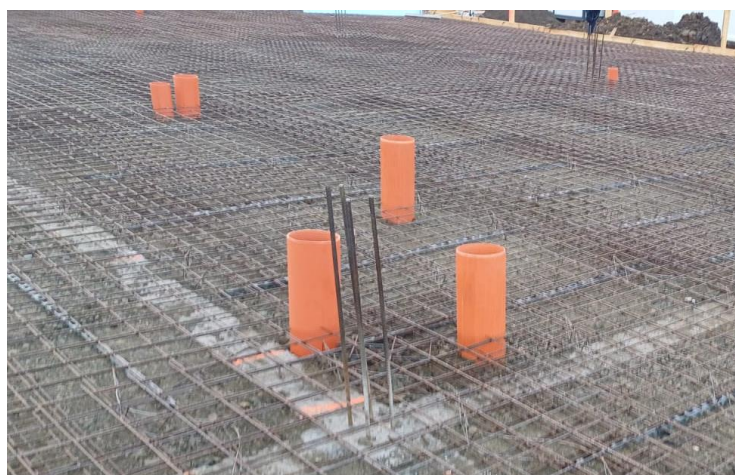
Slika 23. - Proturane cijevi
