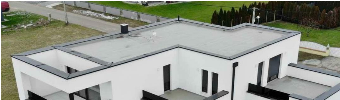
Slika 3.5.1. Izgled TPO folije na krovu
