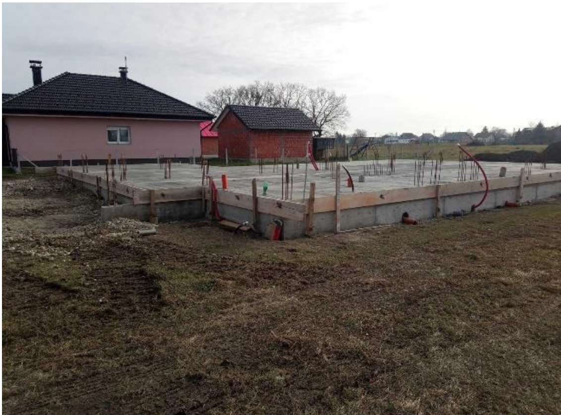
Slika 3.3.1 Betoniranje nadtemeljnih serklaža i AB podne ploče
