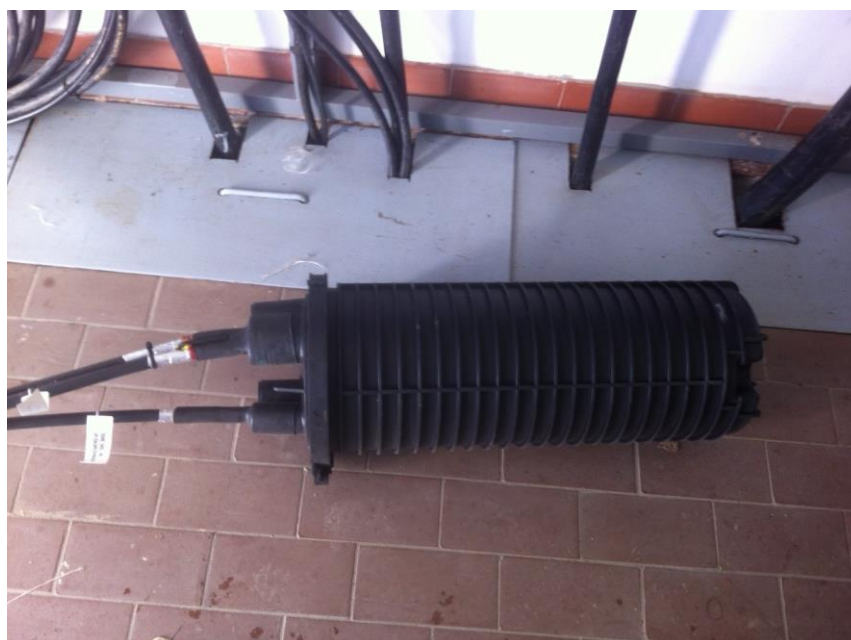
Slika 3.8. Optička spojnica (izvor: autor)
