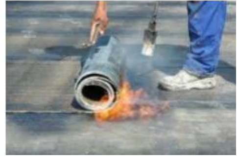
Slika 5.15 Izgled tkanine za bitumenizaciju i postupak bitumeniziranja lijepljenjem [51]
