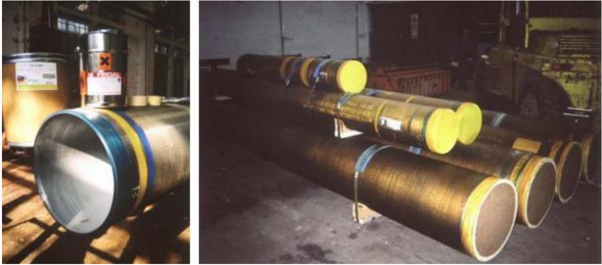
Slika 5.25 Privremena zaštita unutrašnjosti cijevi praškastim inhibitorima [55]
