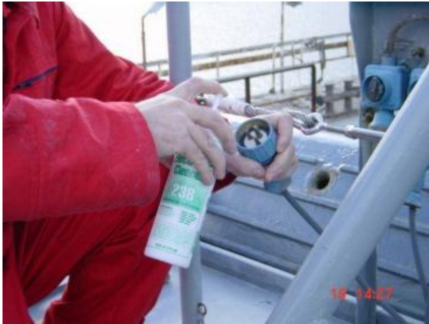
Slika 5.26 Primjena inhibitora za zaštitu električnih kontakata [55]
