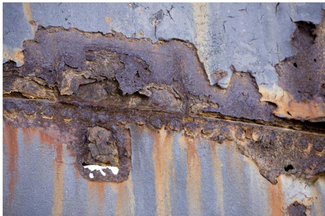
Slika 4.14 Primjer potpovršinske korozije- listanje [25]
