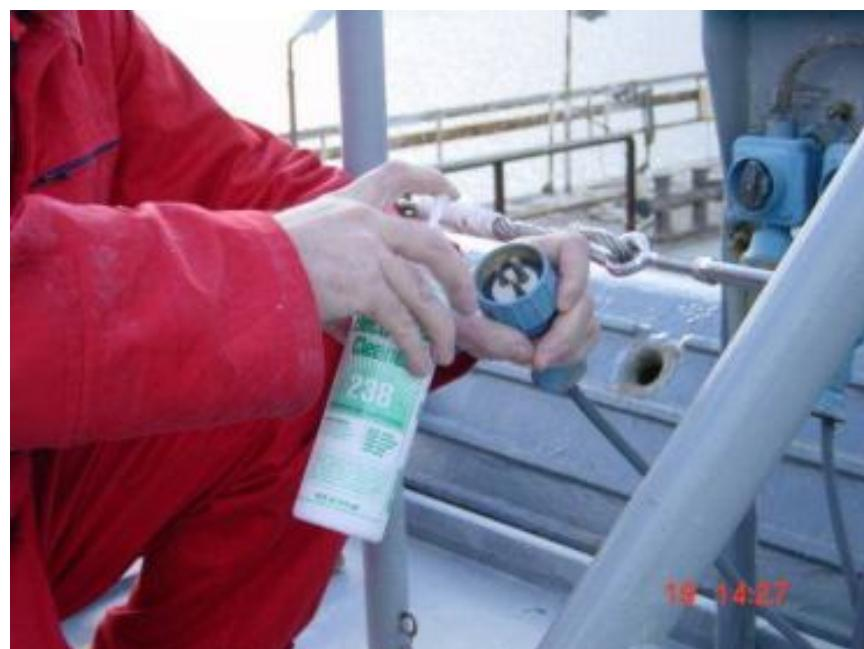
Slika 5.26 Primjena inhibitora za zaštitu električnih kontakata [55]
