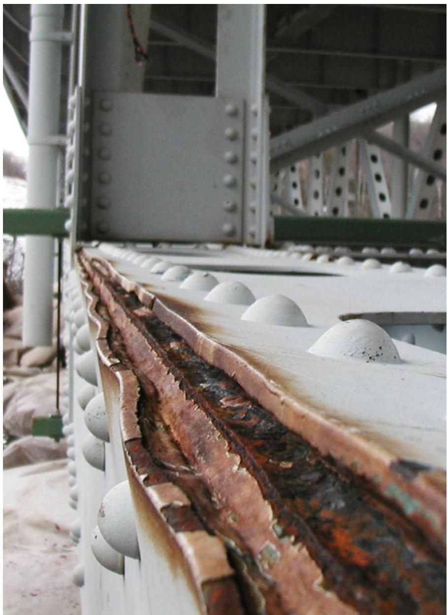
*Slika 4.16 Korozija u procijepu izmedu dva jednaka metala nastala na konstrukciji mosta [30]*
