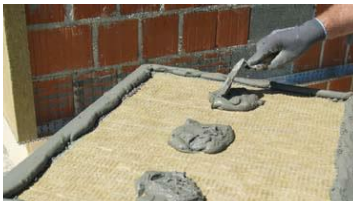
Slika 3.4.1. Građevinsko ljepilo na ploči od kamene vune
