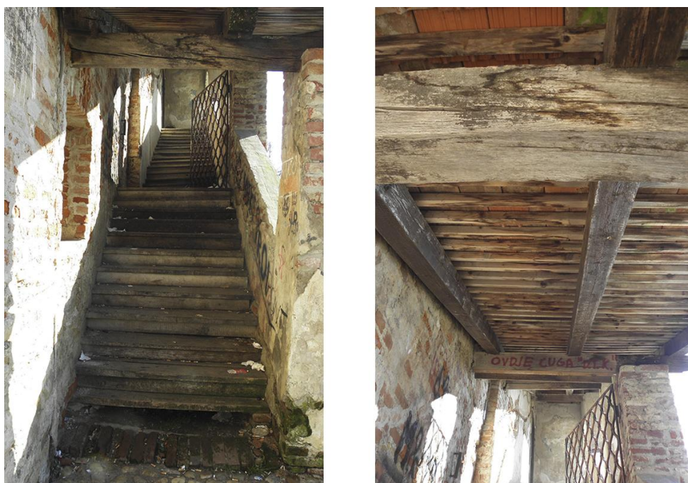
Slika 4.17. Detaljniji prikaz desnog bočnog stubišta
