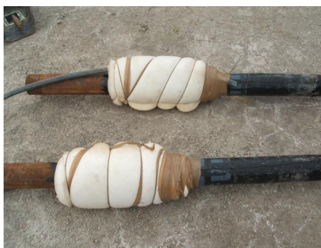
Slika 8.28: Brtva sa spojem čelične i okiten cijevi
