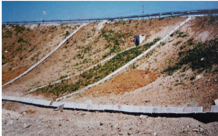
Slika 3.1: Otvoreni kanal niz pokos nasipa do odvodnog jarka
