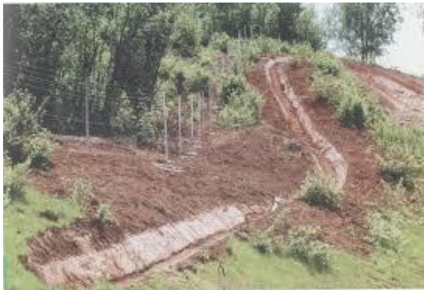
Slika 3.9: Zaštitni jarak na padini iznad usjeka
