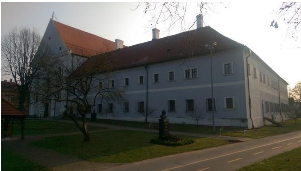
Sl. 6. Franjevačka crkva Presvetog Trojstva sa samostanom
