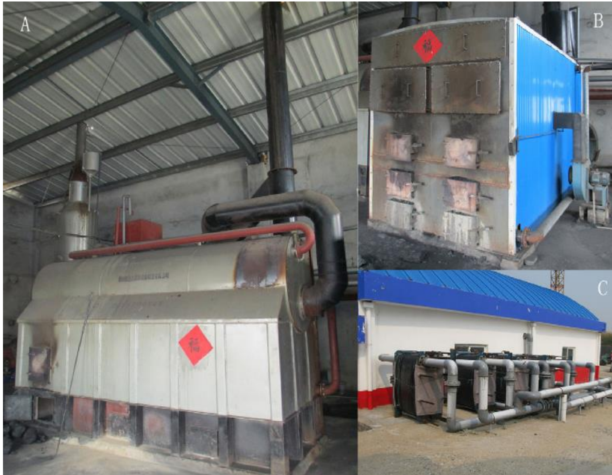
Slika 11. (A, B) Bojler i (C) izmjenjivač topline za sustav vodoopskrbe koji se koristi za uzgoj A. japonicus . (Izvor: A i B od Yucen Bai, 2015; slika C od Shilin Liu, 2015)
