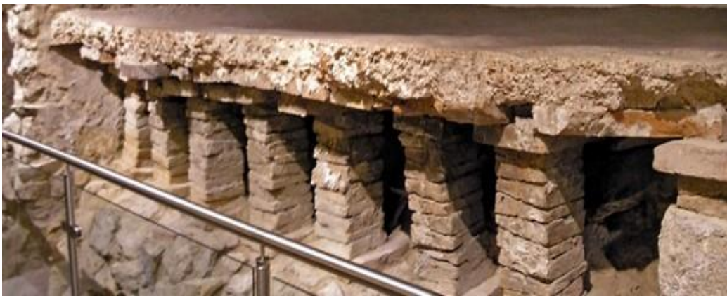
Slika 13: Ostatci podnog grijanja
