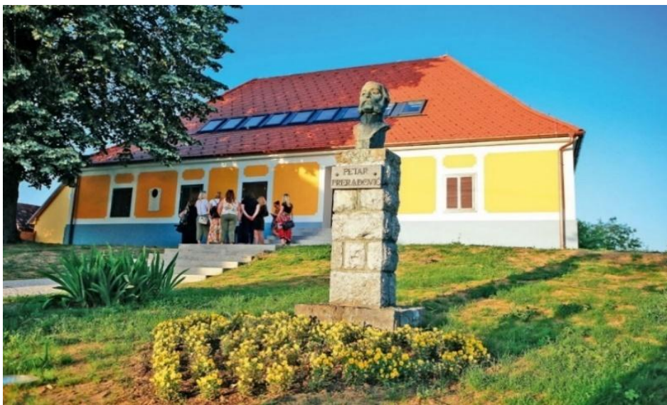
Slika 19. Obnovljena kuća Petra Preradovića
