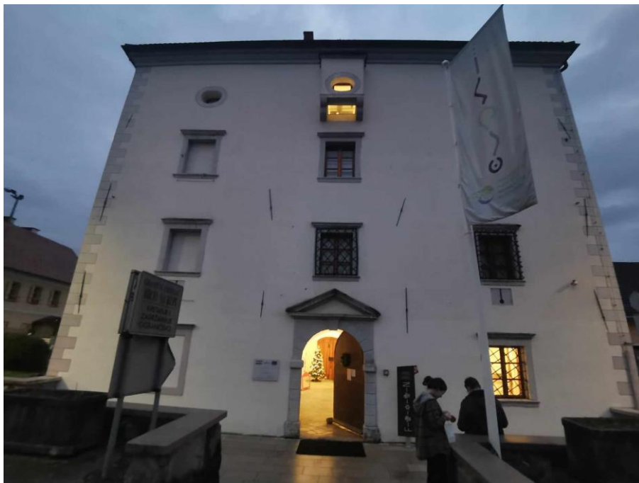
Slika 30. Kaštel Zrinskih u Brodu na Kupu (foto: L. Bajt)
