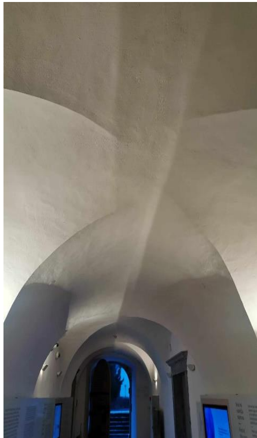
Slika 34. Križni svod u prizemlju (foto: L. Bajt)
