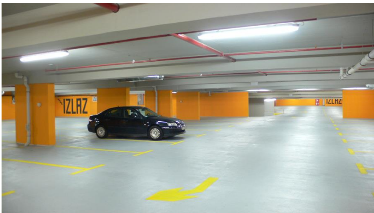
Slika 1. Podzemna garaža Tuškanac
