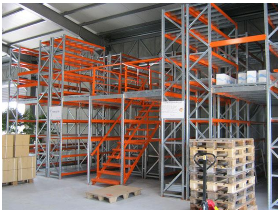
Slika 14. Regal sa skladišnom galerijom
