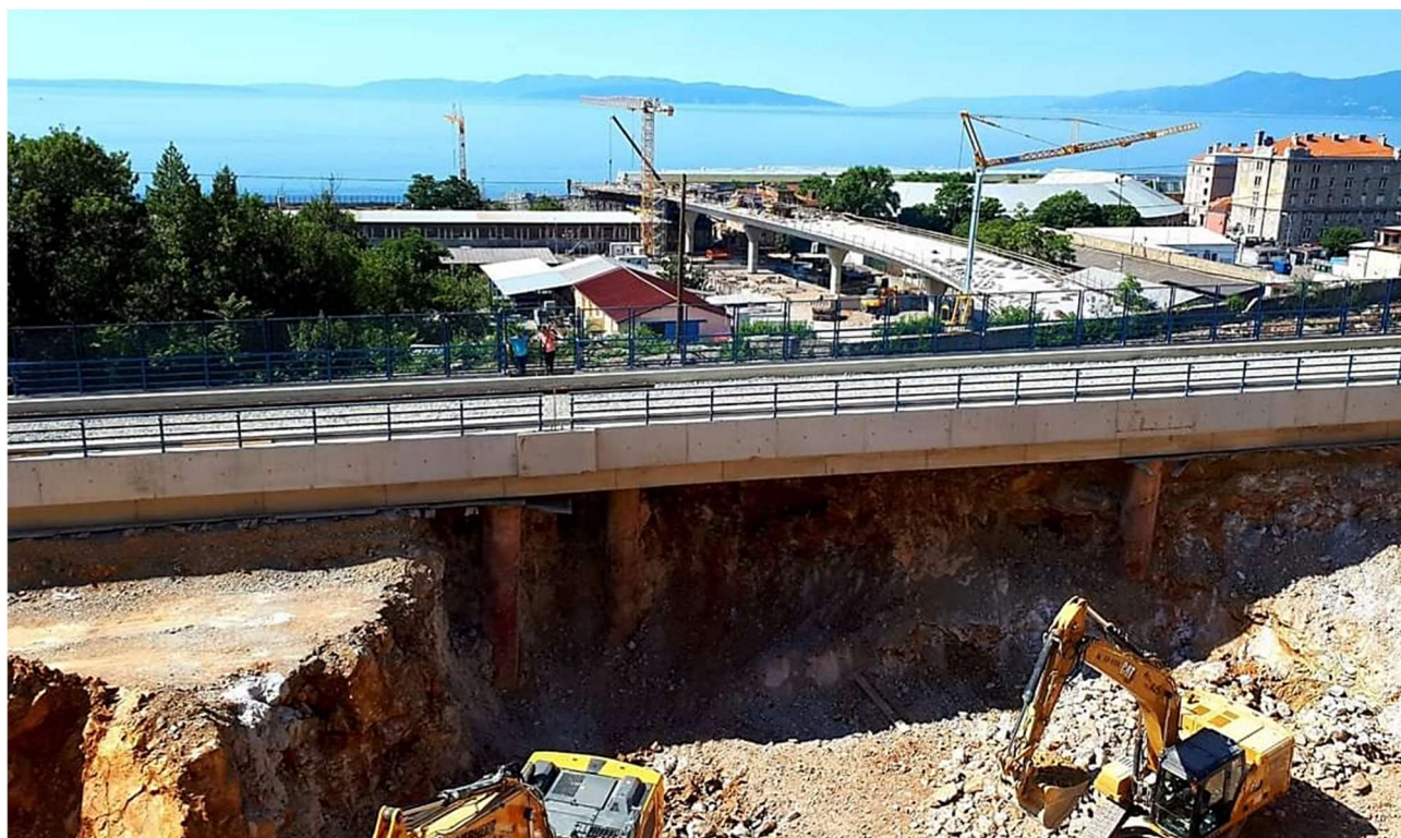
Slika 27 - Radovi izgradnja D-403
