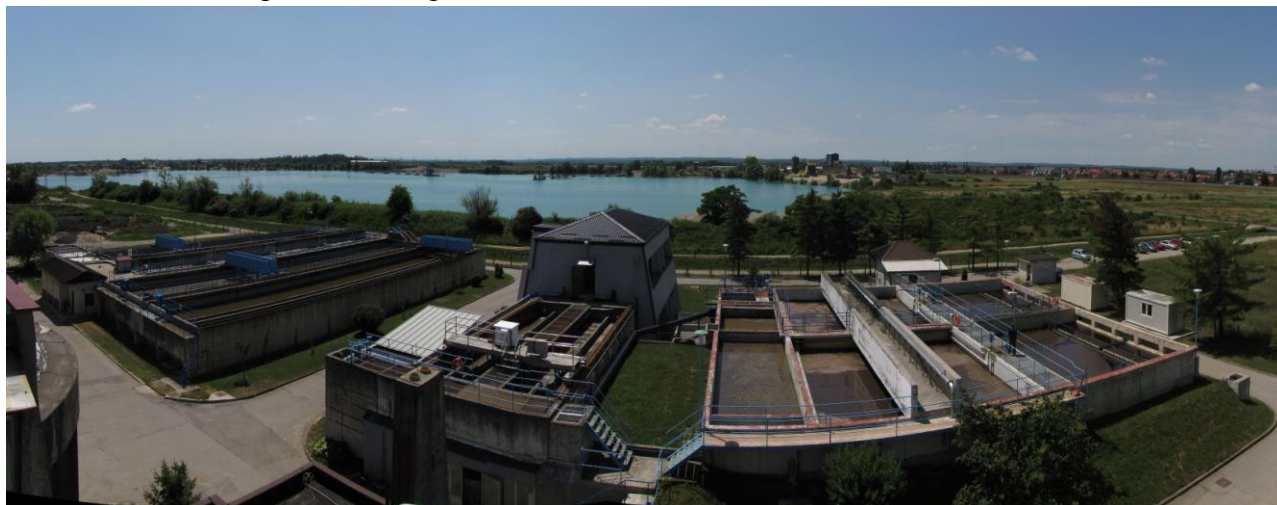
Slika 1. Pročištač otpadnih voda grada Velika Gorica
