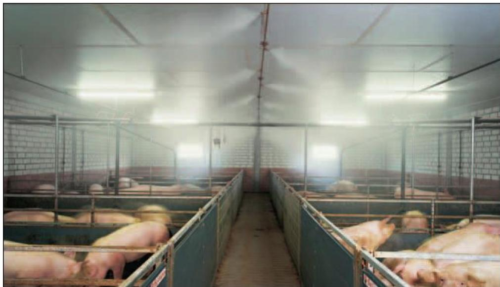
Slika 18. Prikaz rada CombiCool sustava za hlađenje
