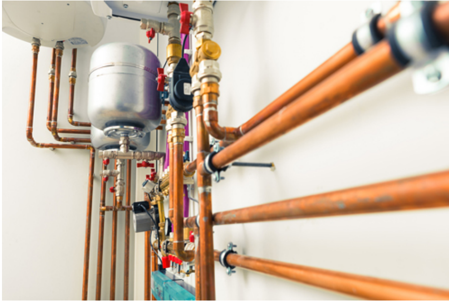
Slika 7.4. Primjena cijevnih spojnice za bakrene cijevi [62]
