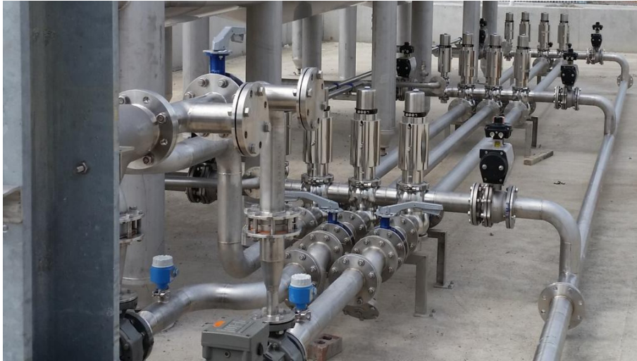
Slika 7.1. Primjena čeličnih prirubnica [58]
