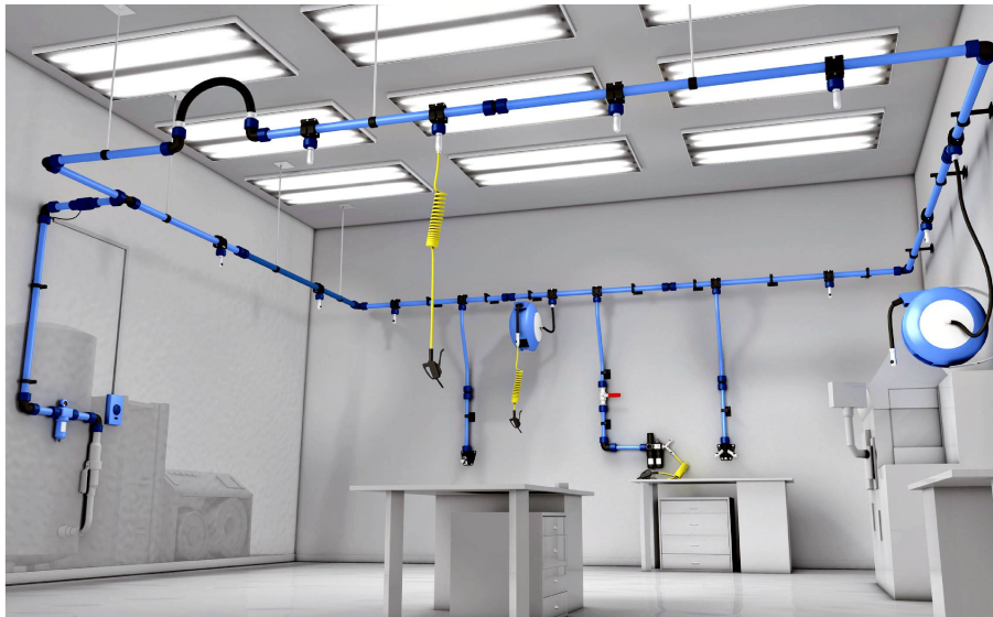
Slika 2.2. Cijevni priključci u zračnom cijevnom sustavu [4]
