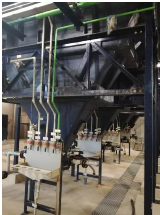
Slika 21 Lamelni taložnici.
