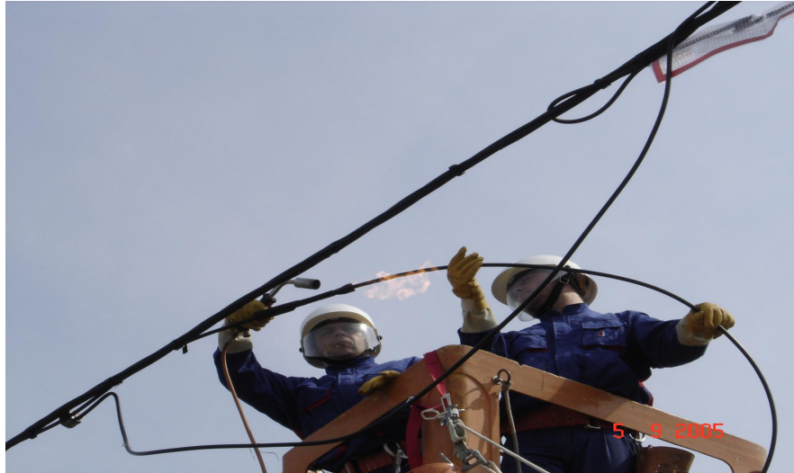
Slika 22. Popravak oštećenog vodiča [Vlastiti izvor]
