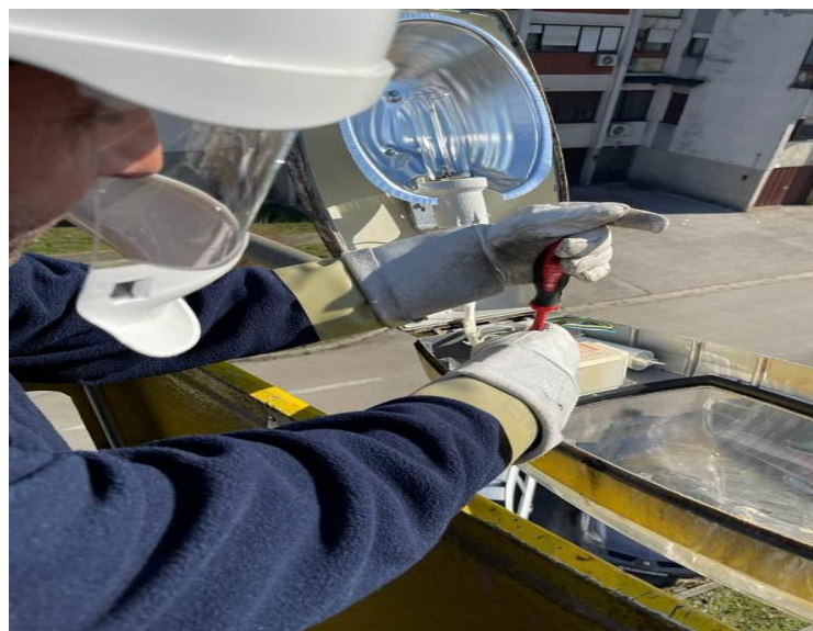
Slika 29. Zamjena prigušnice u svjetiljci javne rasvjete [Vlastiti izvor]
