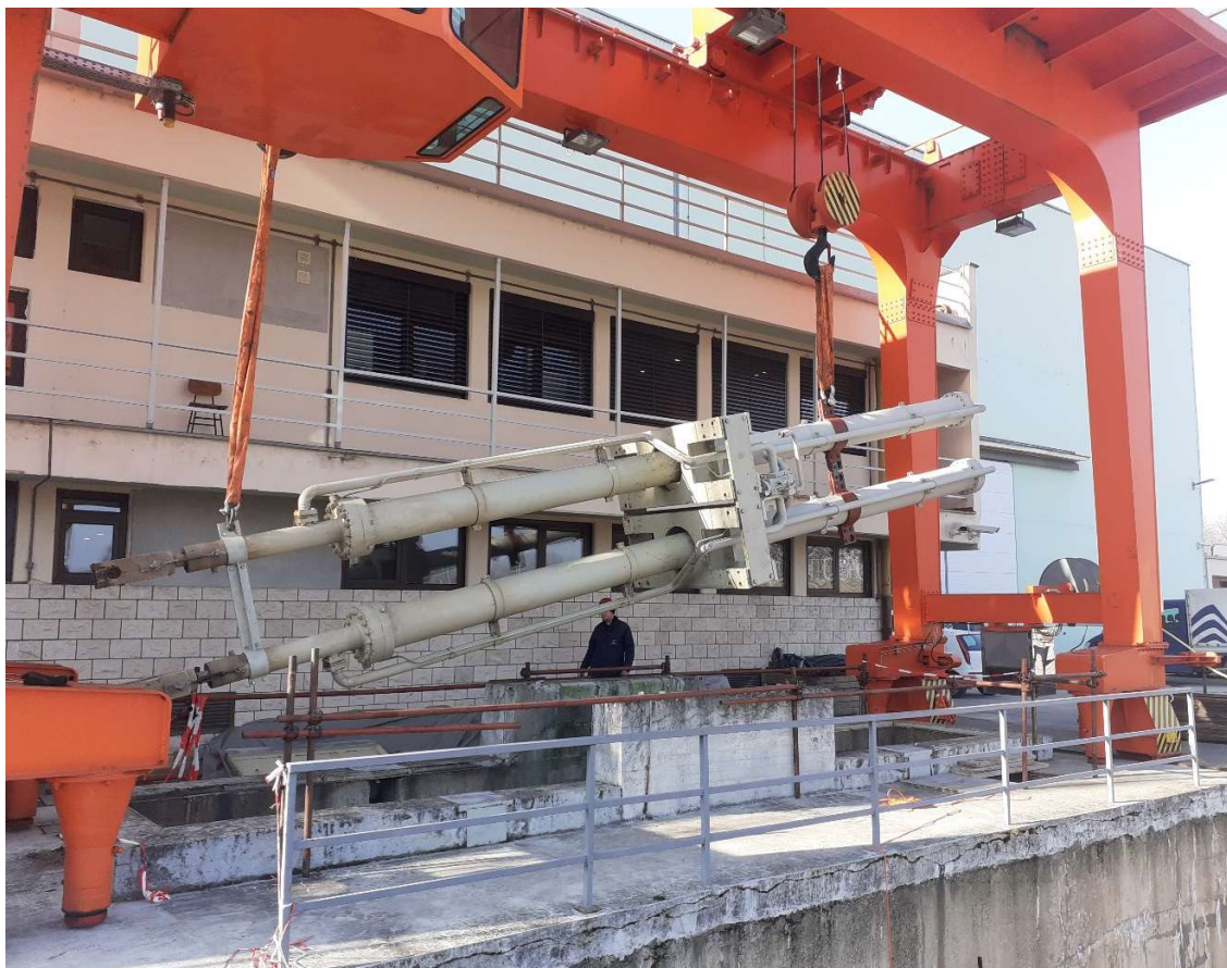
Slika 4.16 Izvlačenje servomotora portalnom dizalicom
