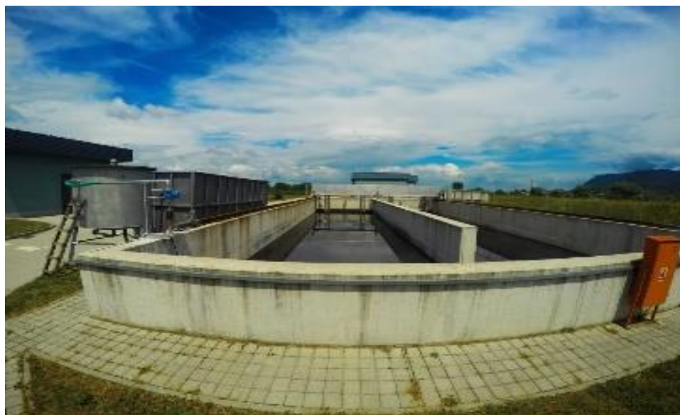
Slika 5. Primarna taložnica (UPOV Zaprešić, 2017).
