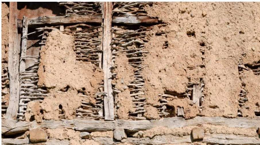
Slika 1. Primjer tradicionalne kompozitne tvorevine [4]
