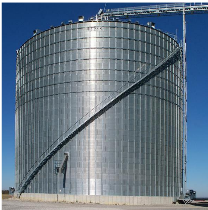
Sl.5. Čelični silos [6]
