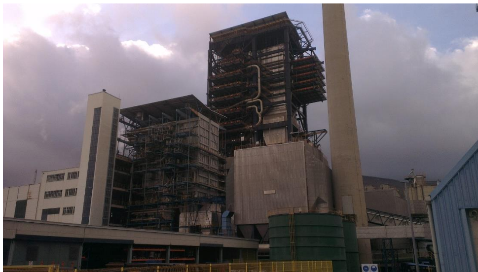
Slika 3. Prikaz postrojenja TE Plomin 1 i 2.
