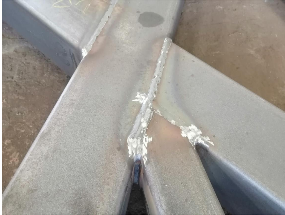
Slika 60. Zavar sklopa kvadratnih cijevi
