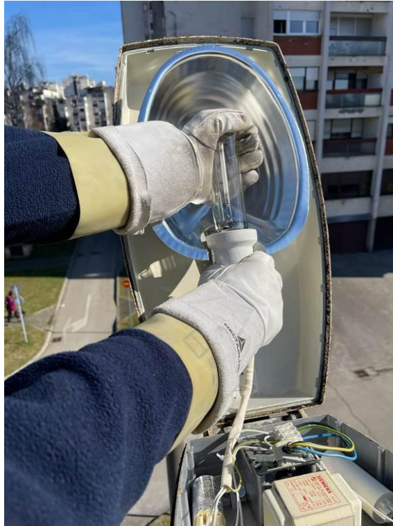
Slika 30. Zamjena žarulje u svjetiljci javne rasvjete [Vlastiti izvor]
