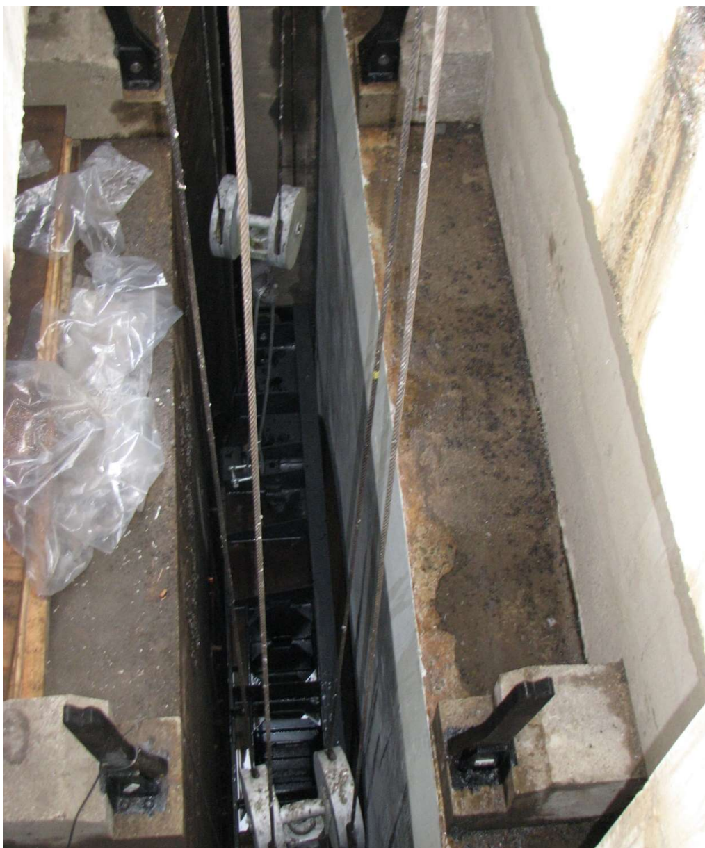
Slika 3.3 Pogled na betonsku brtveću stijenu u niši zatvarača
