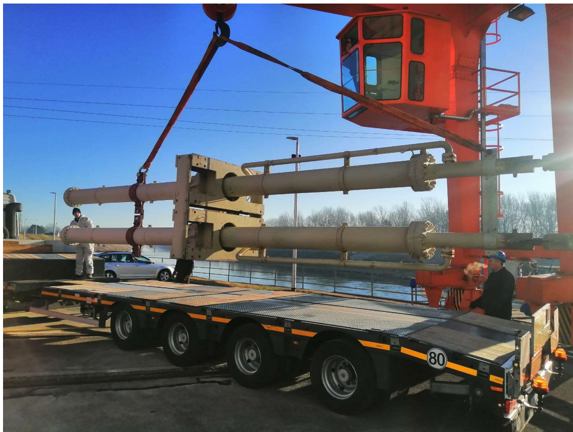
Slika 4.18 Utovar servomotora na labudicu za transport
