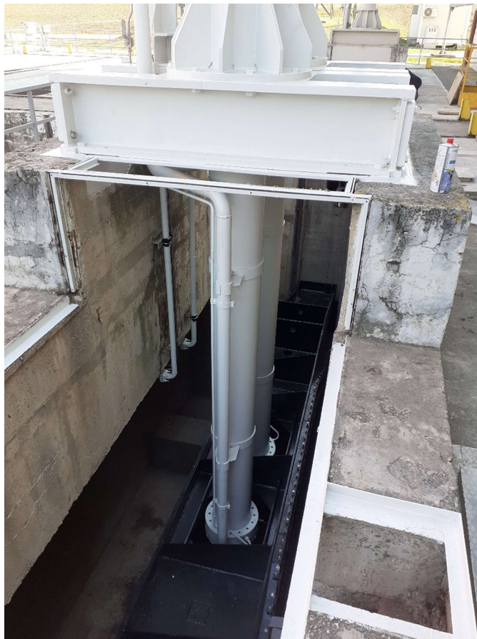
Slika 4.32 Montaža servomotora i zatvarača
