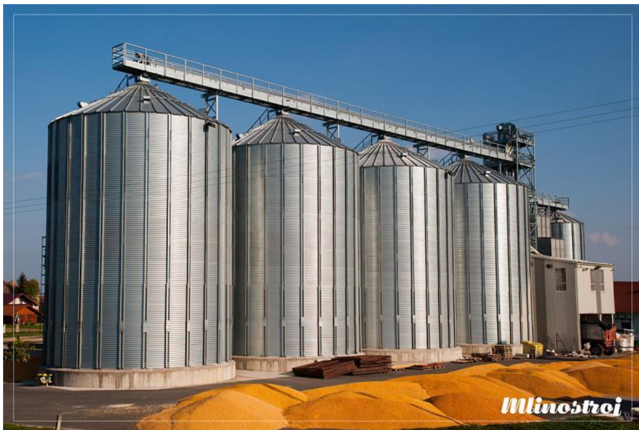
Slika 10. Silosi kao specijalizirano skladište
