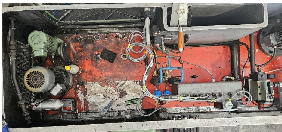
Slika 32. Izgled kućišta hladnjaka nakon ugradnje novog sustava[Autor]
