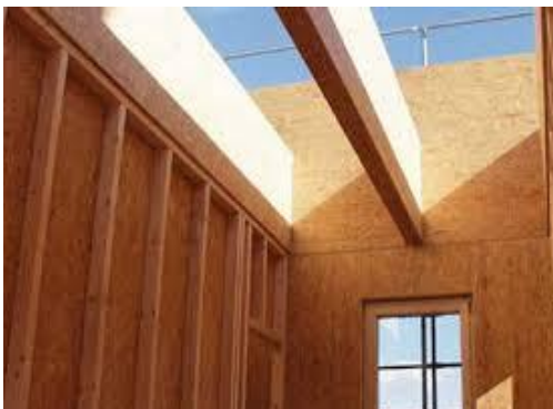
Slika 36. Izrada kuće od kompozitnih ploča [2]
